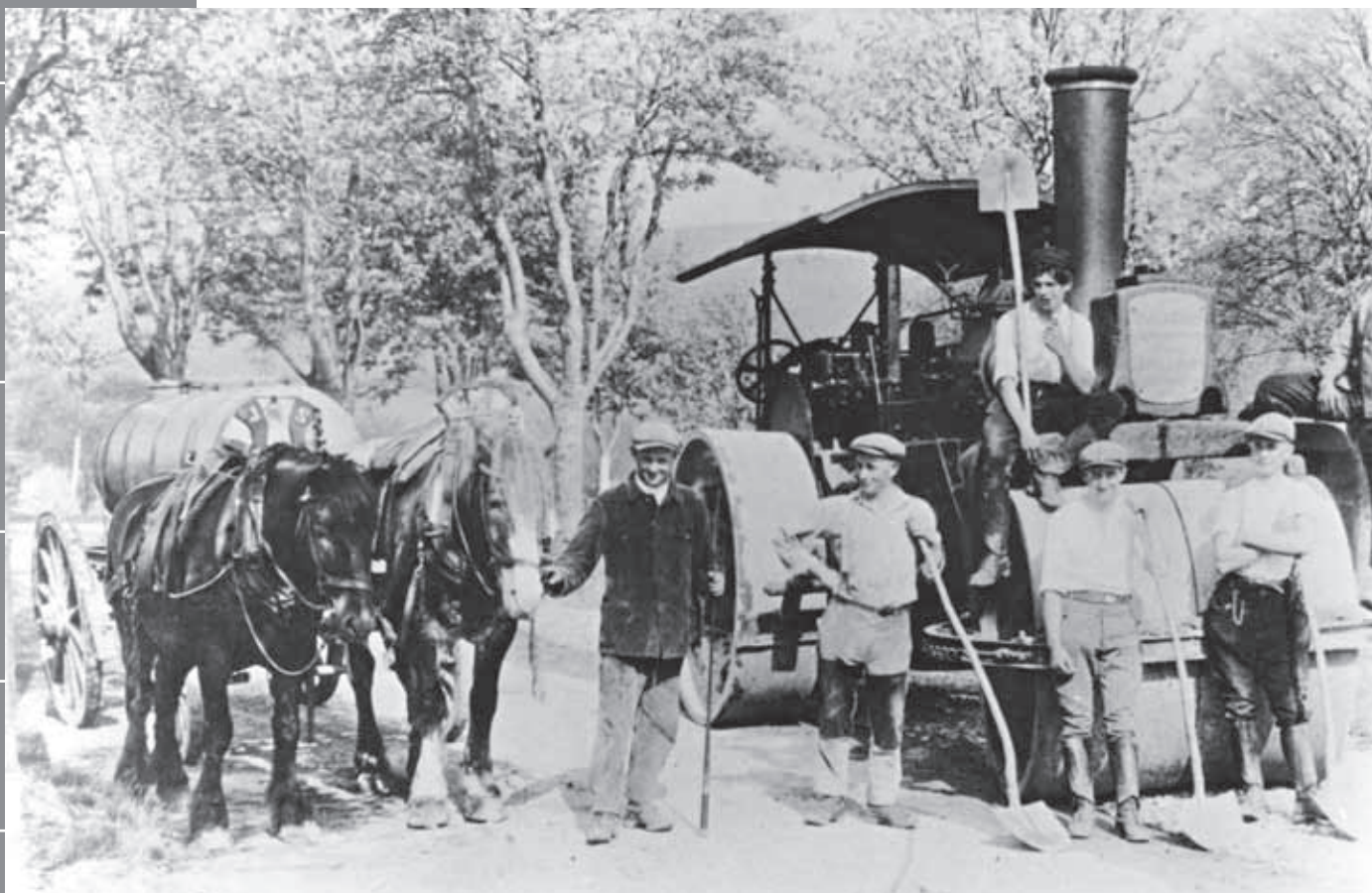
Erst spät werden die Straßen in der Eifel ausgebaut. Gepflastert wird von Hand.
